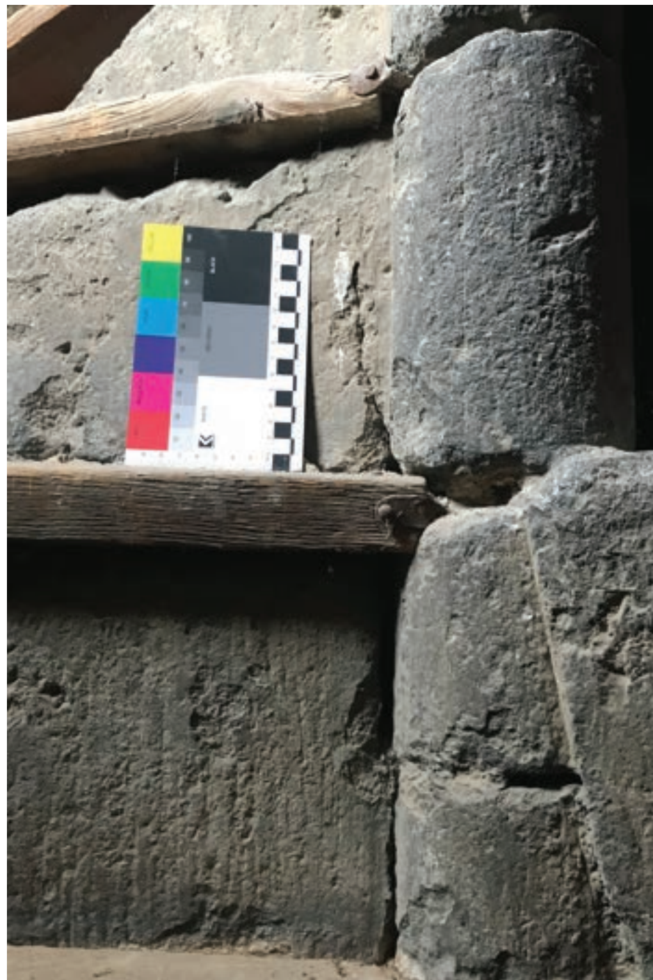
10. Rozdílná skladba bloků tvořících stupně schodiště: nahoře stupeň s jedním ramenem a válcem sloupu z jednoho kusu, dole dvouramenný stupeň s dvoudílným válcovým segmentem středového sloupu. Poškozeno slabší trhlinou.
