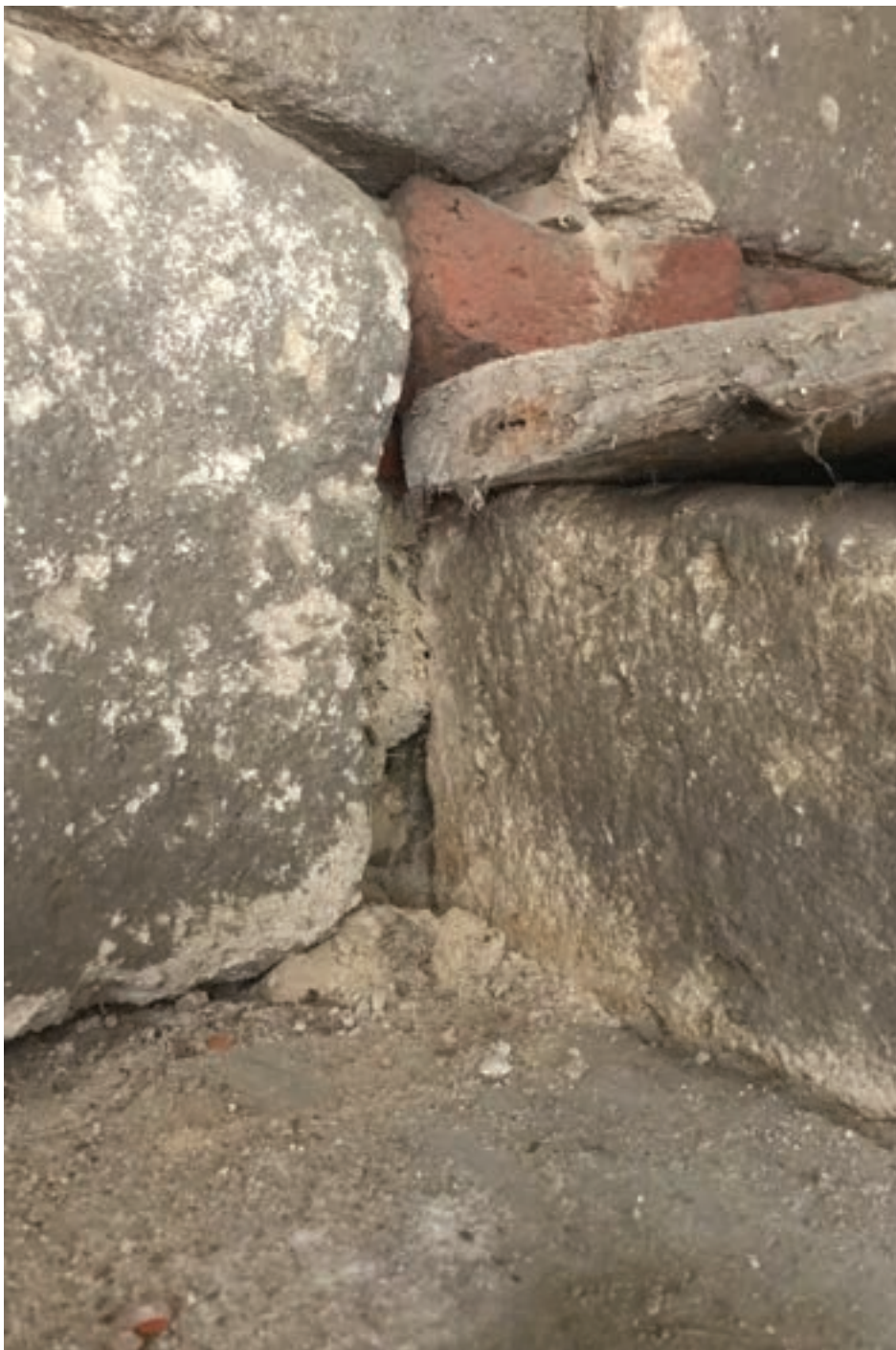
11. Detail vsazení schodišťového stupně do zdiva tubusu věže, nesoucího schodiště
