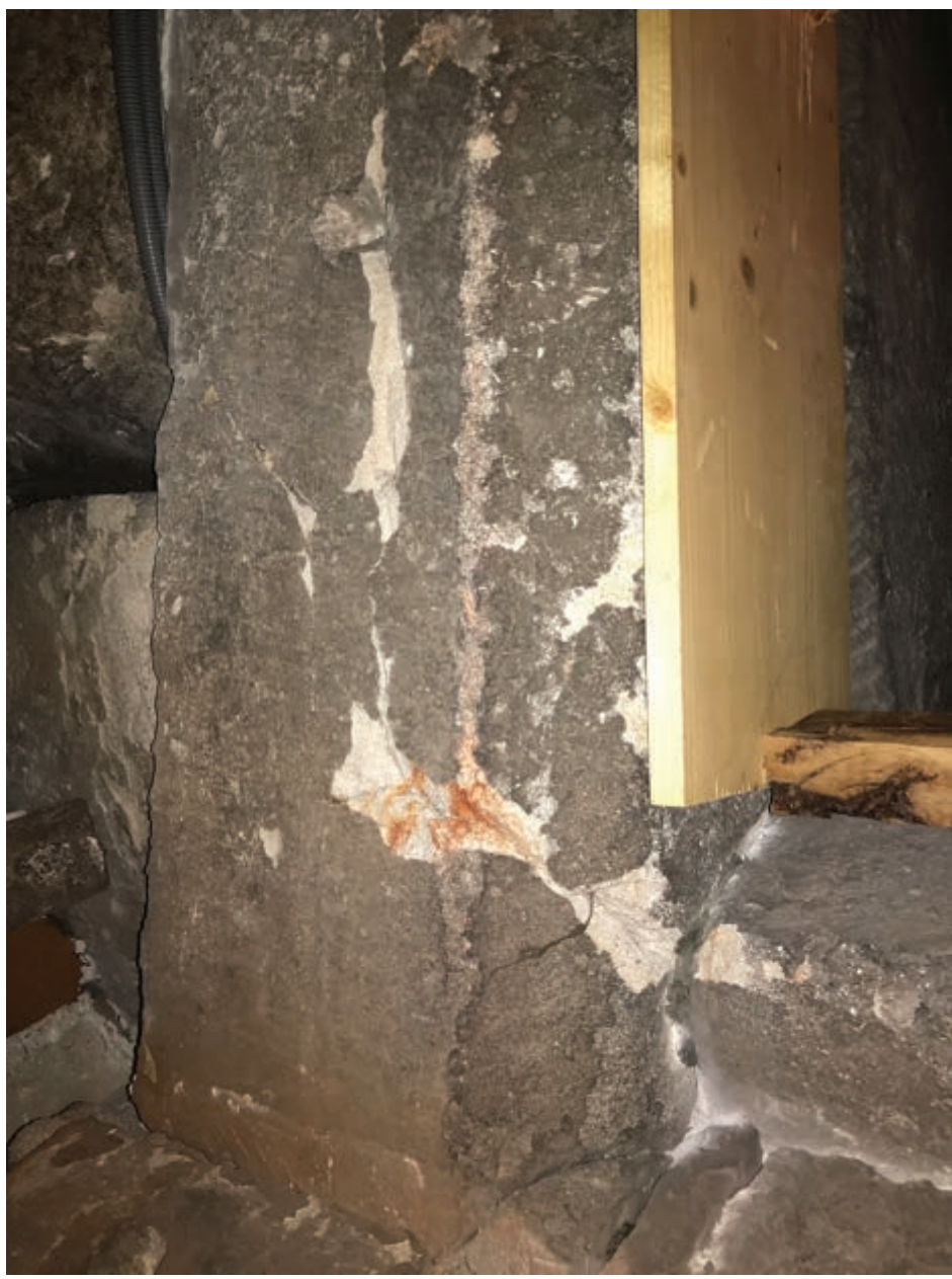
28. Havarijní stav překladu portálu, trhliny procházející celou hloubkou bloku
