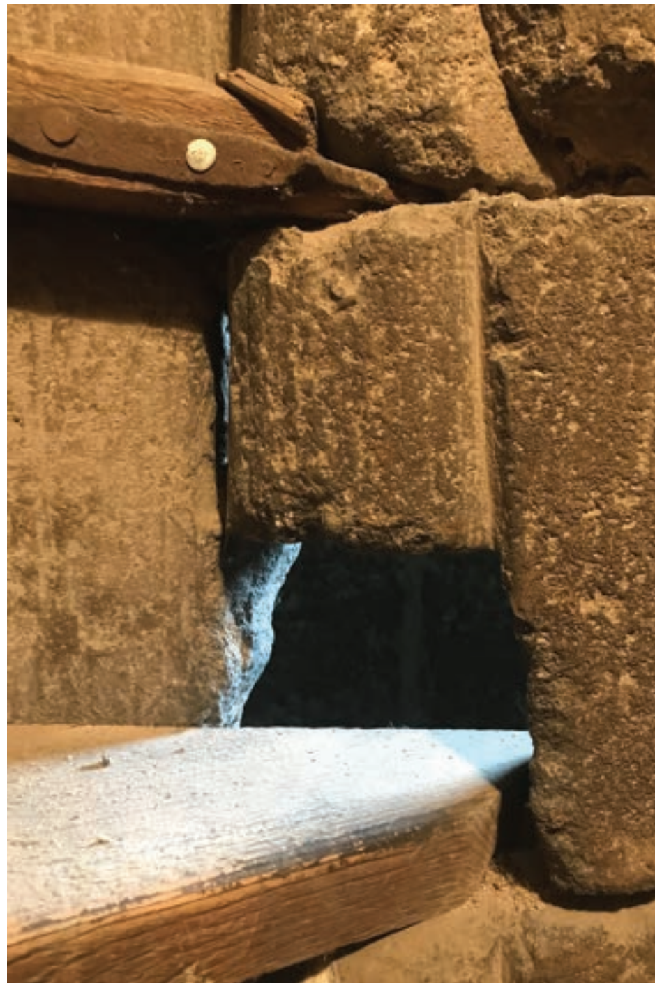
12. Chybějící část válce u jednoho ramene dvouramenného stupně
