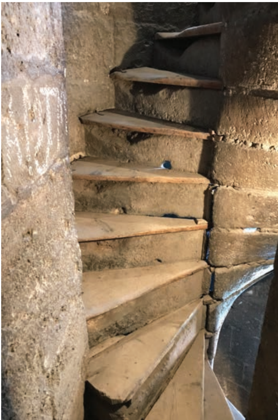
3. Pohled na středovou osu dvojitého schodiště v úrovni 3 NP. Viditelné otevření spáry mezi stupni vnějšího a vnitřního vřetene
