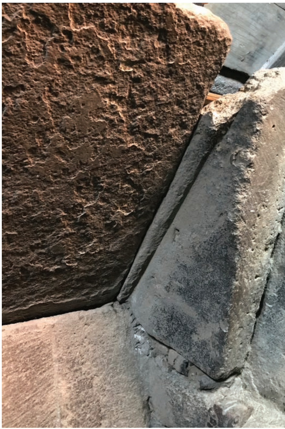
17. Konzola a překlad nesoucí kamennou desku kryjící vstup na půdu a sestup do pokladnice
