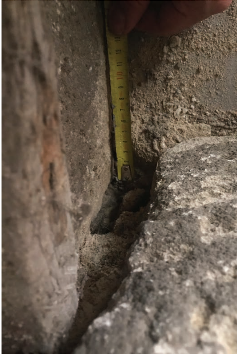
13. Hloubka vsazení stupně do zdi vá věže
