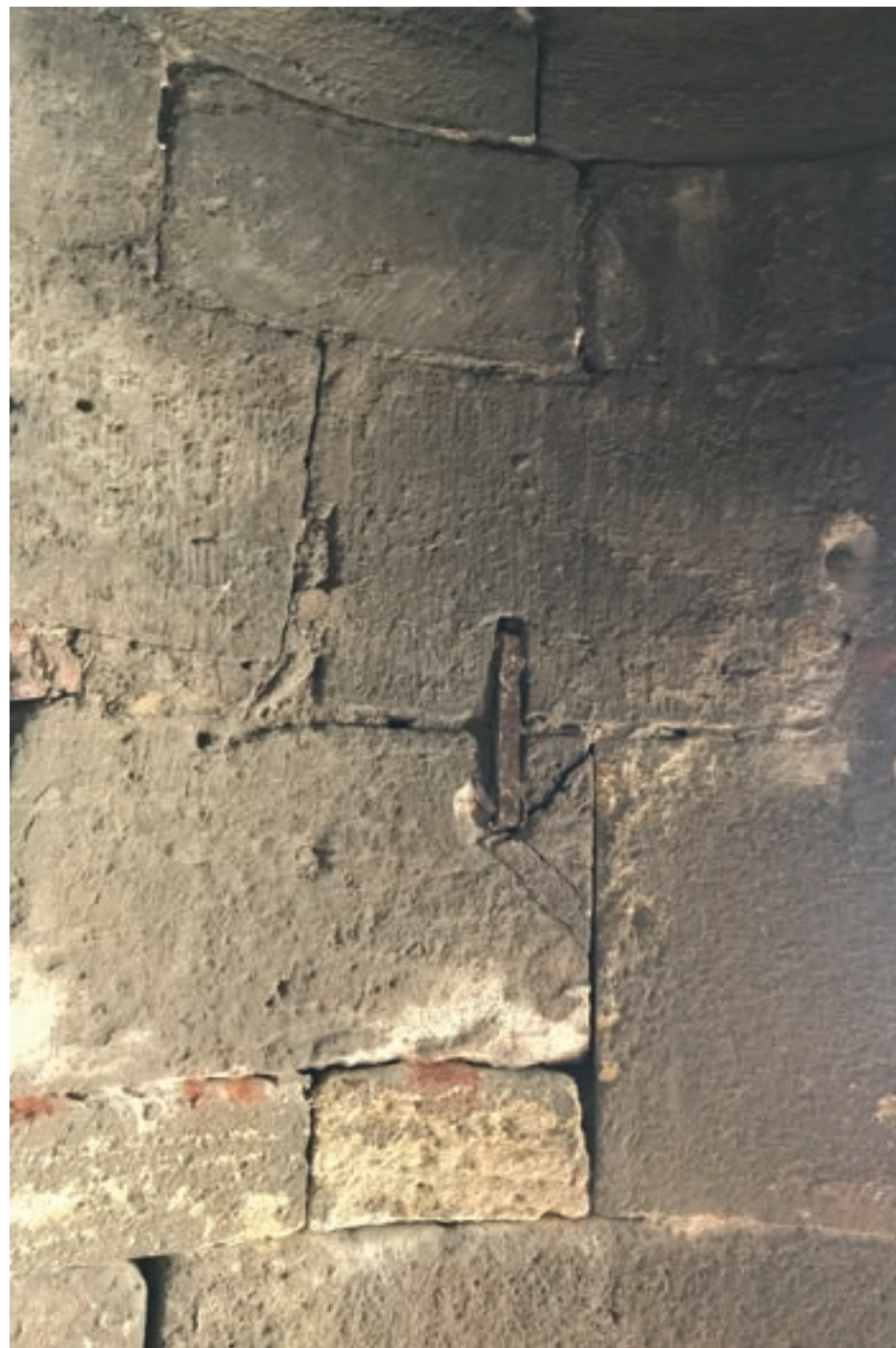
4. Povrch čistě opracovaných kamenných kvádrů, z nichž je složen tubus věže nesoucí schodiště. Druhotně vložená kovová kramle
