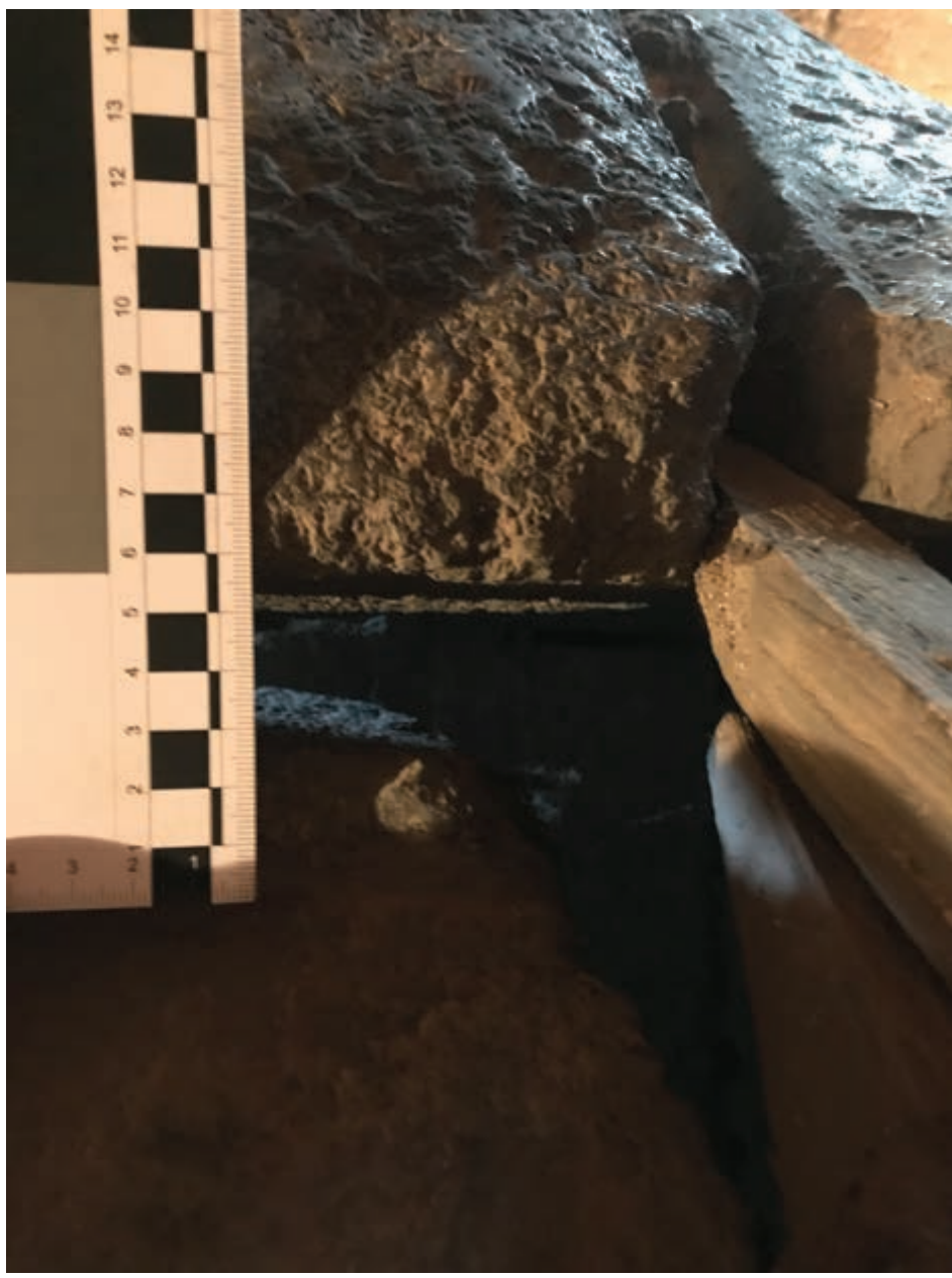
7. Rozevřená spára mezi bloky vnějšího a vnitřního schodiště nad úrovní 3NP
