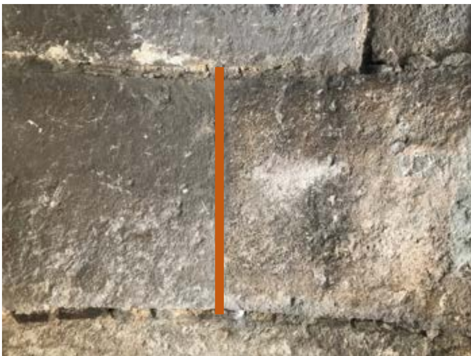
Obr. 1. Kvádrové zdivo po straně uličního vstupu na JZ dvojité vřetenové schodiště, zkouška očištění povrchu. Vlevo stav před očištěním vysavačem a následně regulovatelnou vodní párou, vpravo stav po očištění
