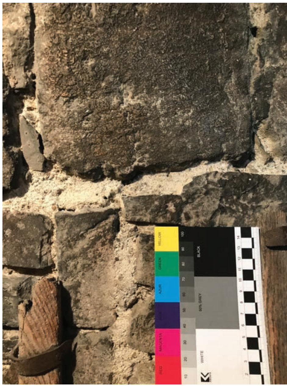
8. Detail obr. 6. Spára mezi cihlovou dozdívkou a původním kamenným stupněm vyplněná vápennou maltou. Spára nese známky statických poruch
