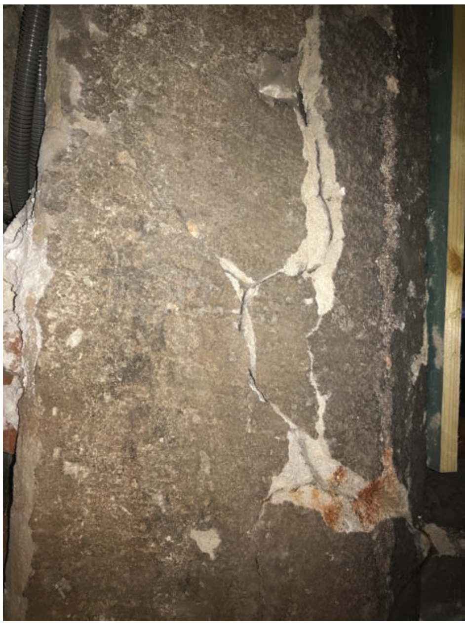
27. Havarijní stav překladu portálu, trhliny procházející celou hloubkou bloku
