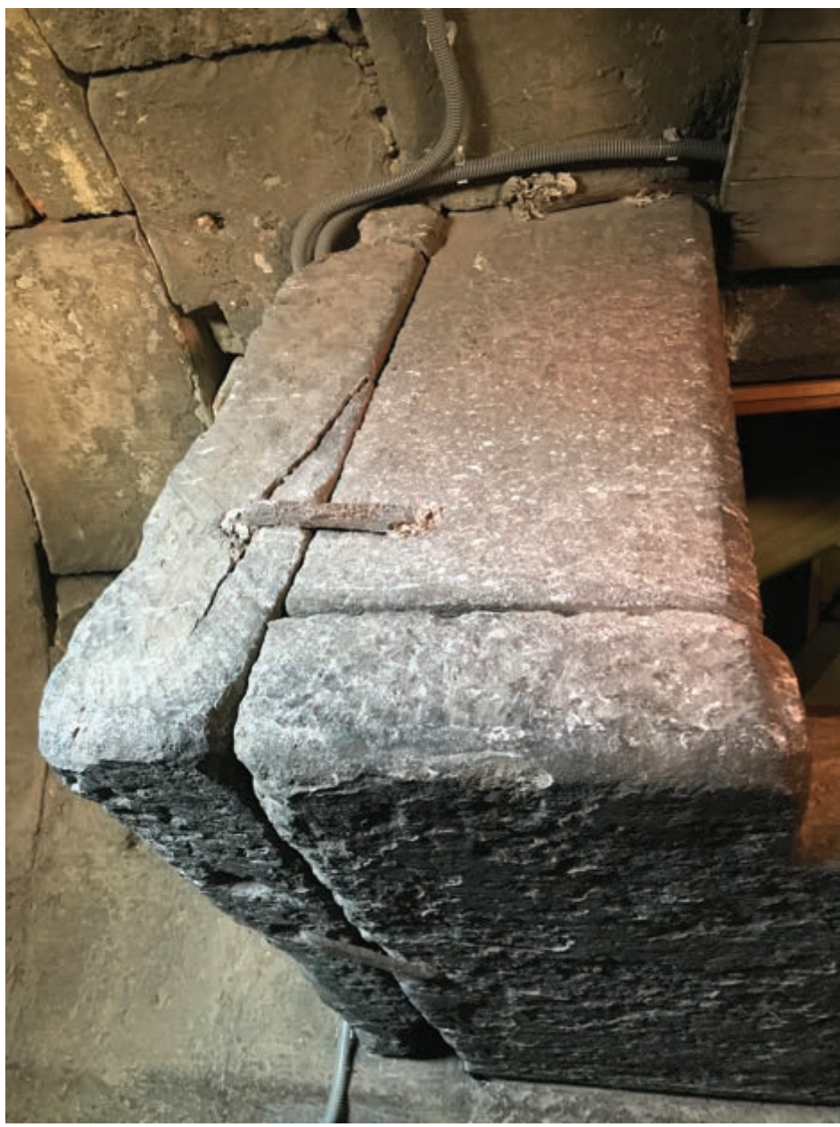
17. Konzola a překlad nesoucí kamennou desku kryjící vstup na půdu a sestup do pokladnice
