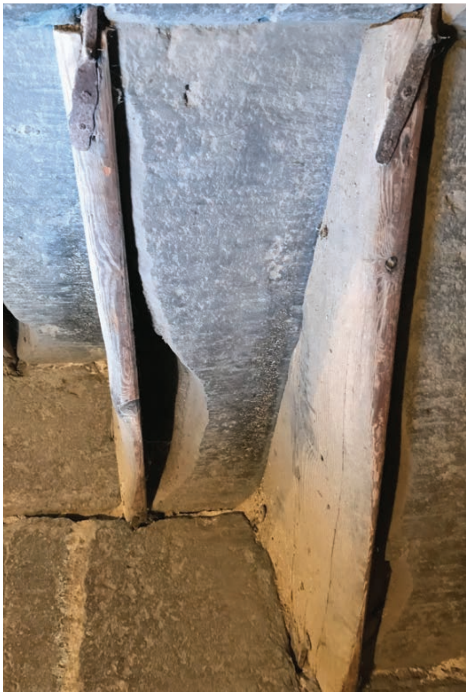
5. Druhotně osazené dřevěné nášlapné desky kotvené pomocí kovových skob do přilehlých spár. Ve hmotě kamenných stupňů jsou patrné rozsáhlé ztráty původní hmoty
