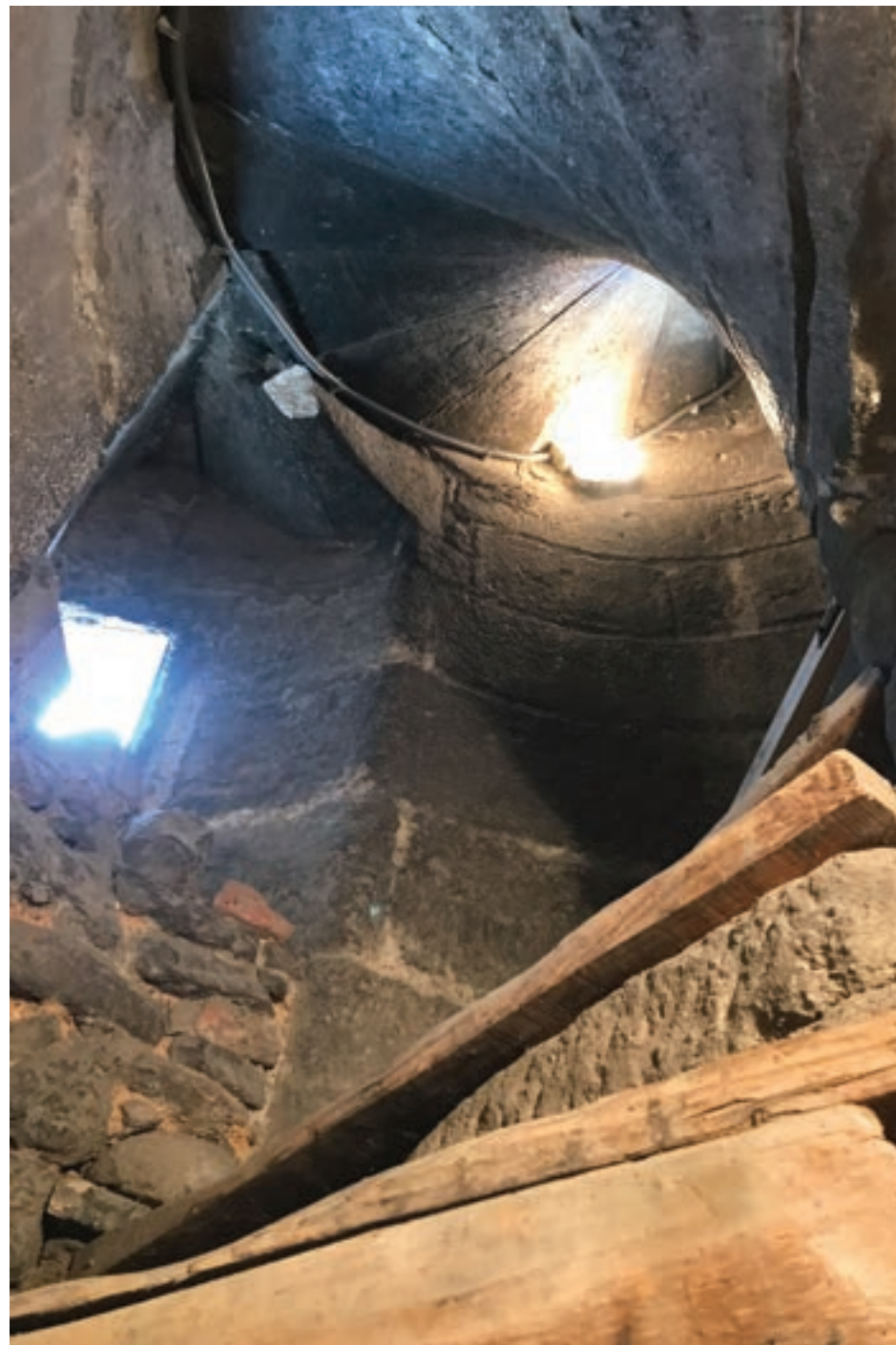
2. Pohled do interiéru tubusu s vnějším vřetem schodiště
