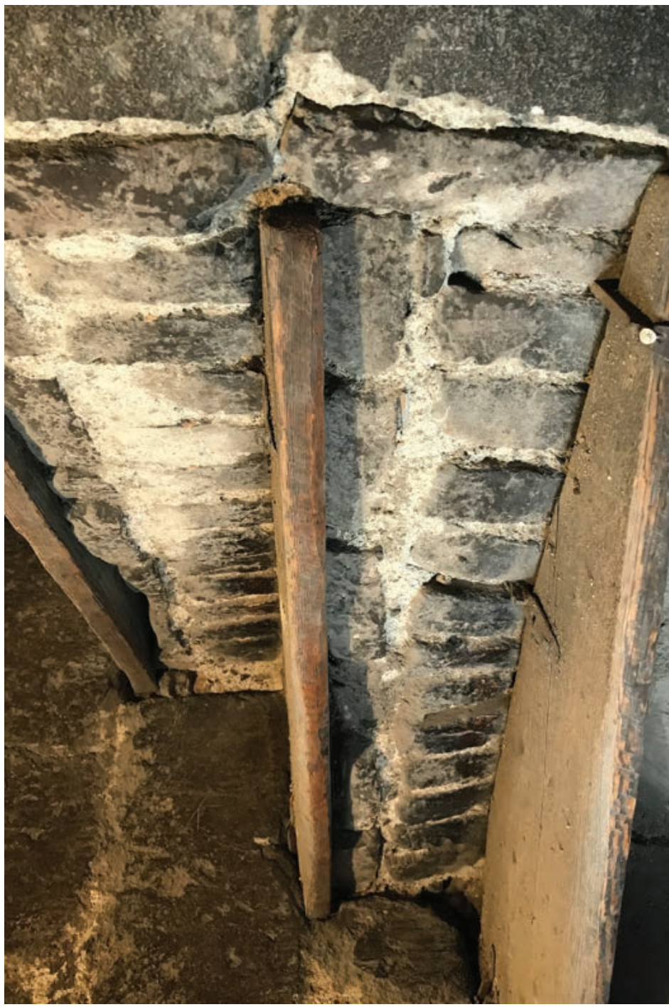
6. Druhotně dozděné cihlové klenby fungující jako náhrada za, v minulosti poškozené, kamenné stupně v úrovni mezi 3NP a 4NP
