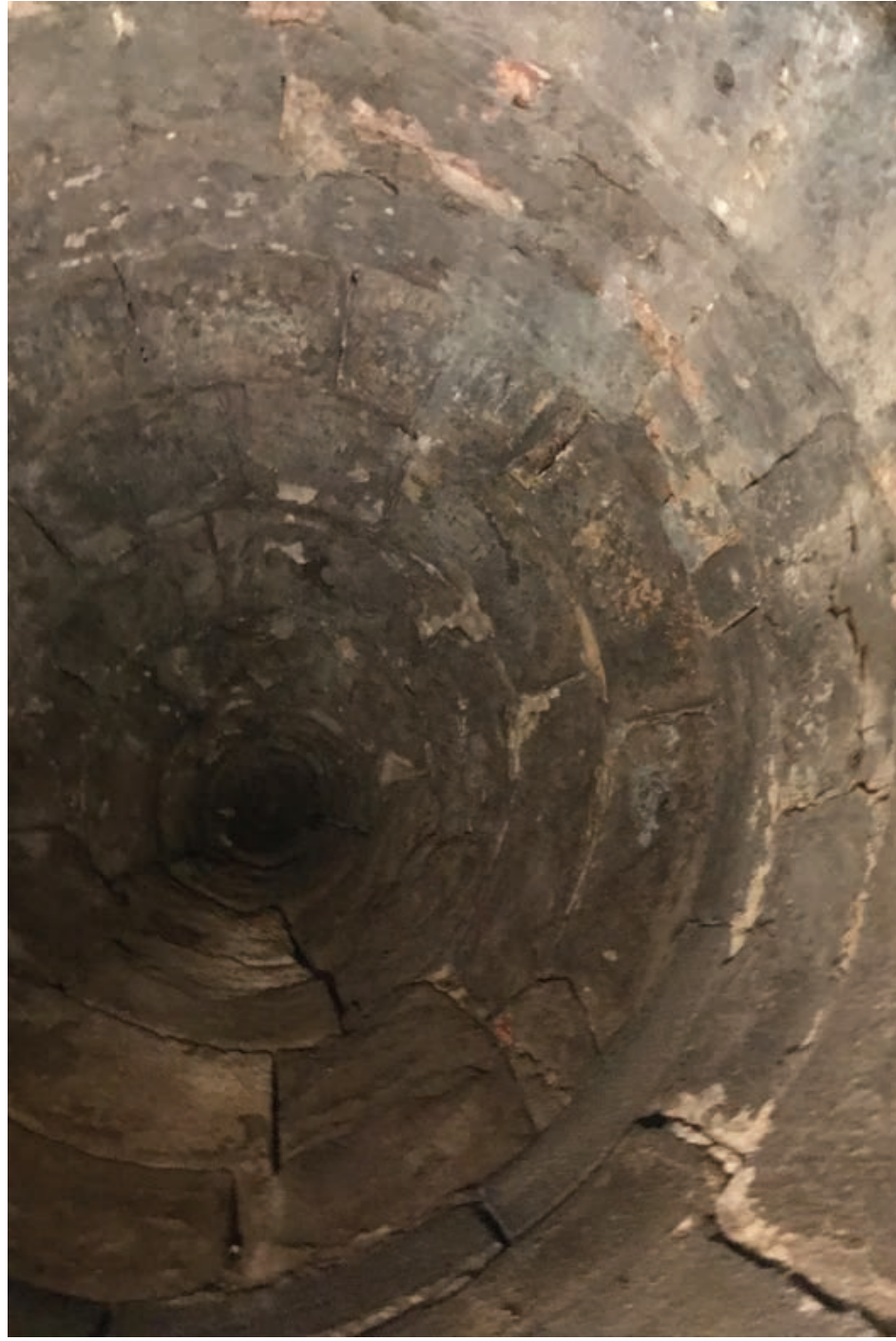
20. Detail předešlého, patrná statická porucha v klenbě
