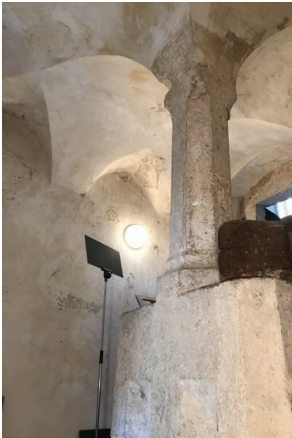
36. Klenba předsíně zaklenutá na středový kamenný pilíř
