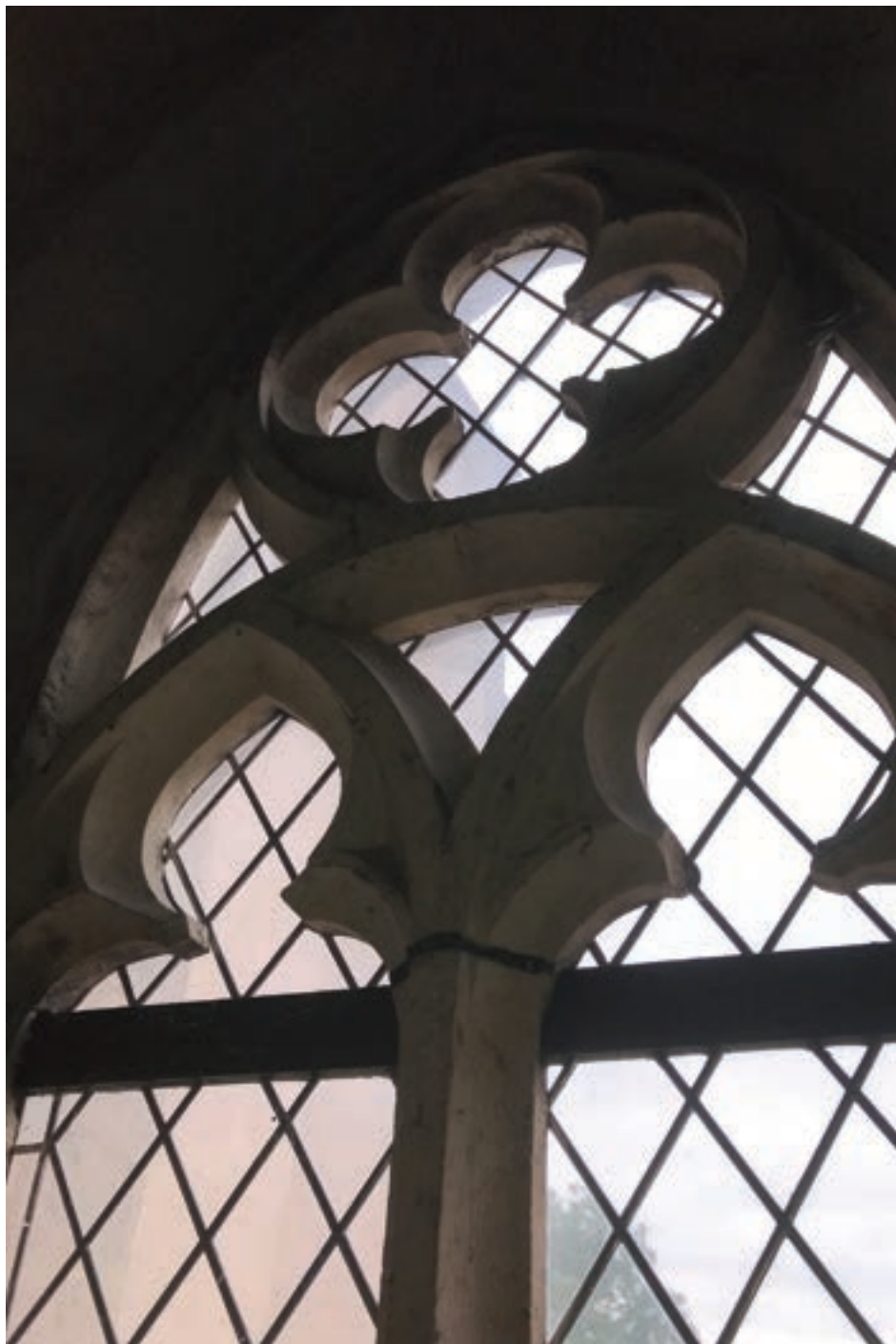
31. Detail okna nahrazeného kopií při rekonstrukci prováděné Ludvíkem Láblerem na konci 19. století. Kružba z hořického pískovce
