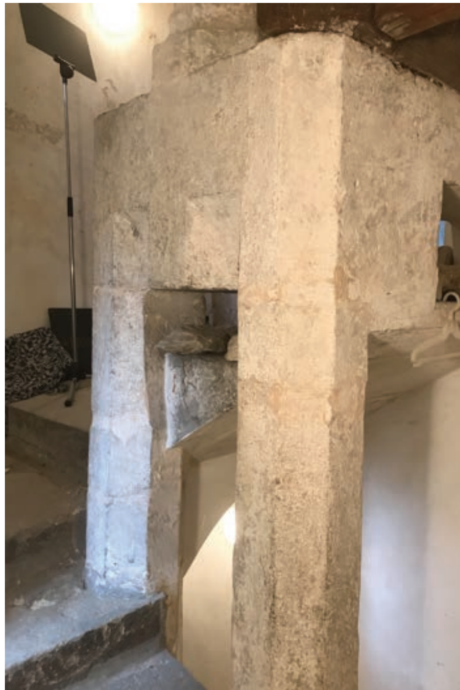
37. Pohled na kamennou stolicí, nesoucí středový pilíř, dvojice sloupu tvoří osu čtyřramenného schodiště
