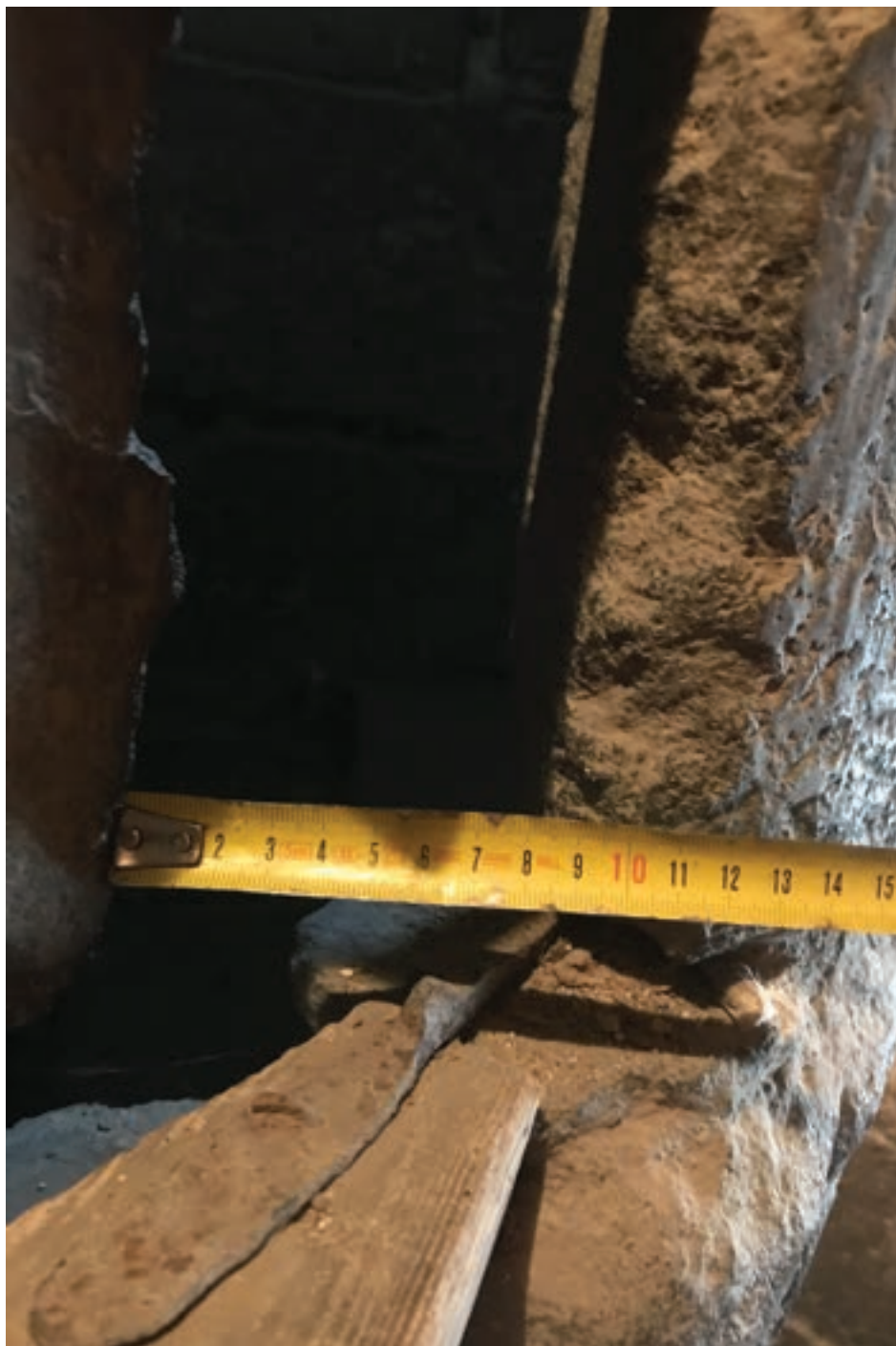
9. Místo největšího rozevření spáry mezi stupni vnějšího a vnitřního vřetene schodiště, zhruba v úrovni 3NP
