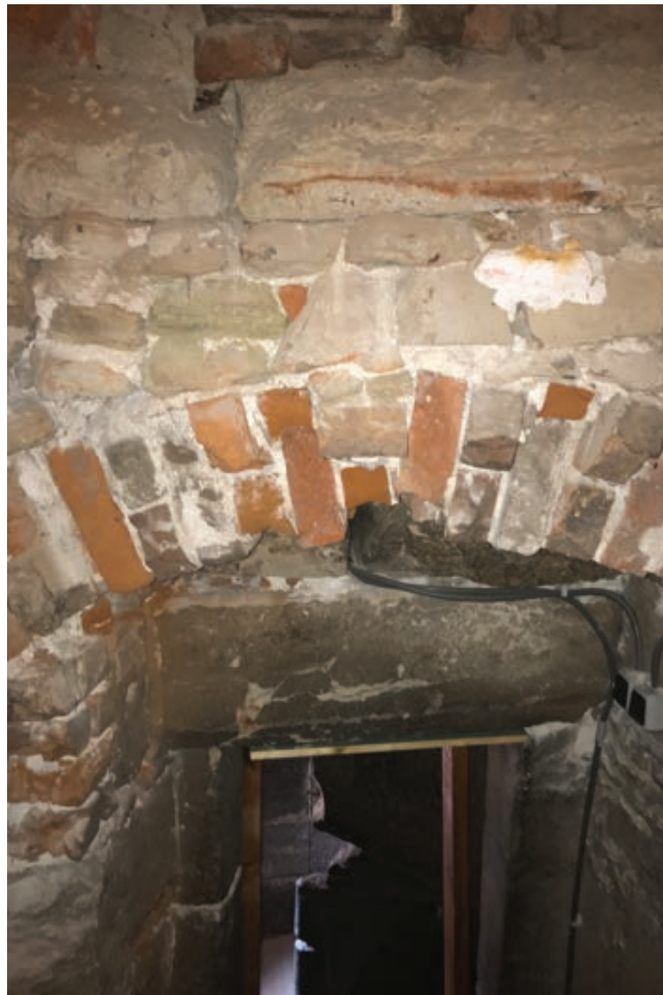
26. Poškození cihlové klenby vylehčující vertikální zátěží překladu v nadpraží portálu
