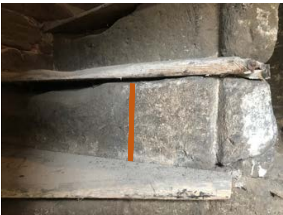
Obr. 2. Zkouška stejného postupu očištění povrchu kamene na schodišťovém stupni a segmentu sloupku. Vlevo stav před očištěním vysavačem a následně regulovatelnou vodní párou, vpravo stav po očištění
